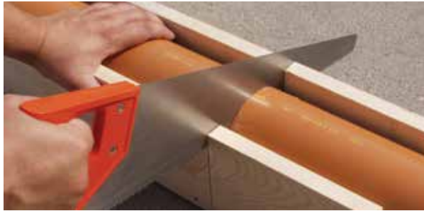
Obrázek 2 Zkracování trubky pilkou
